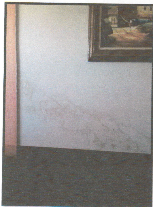
Figura 4- Trincas e fissuras do lado interno e externo da sala da presidência e na sala do arquivo
